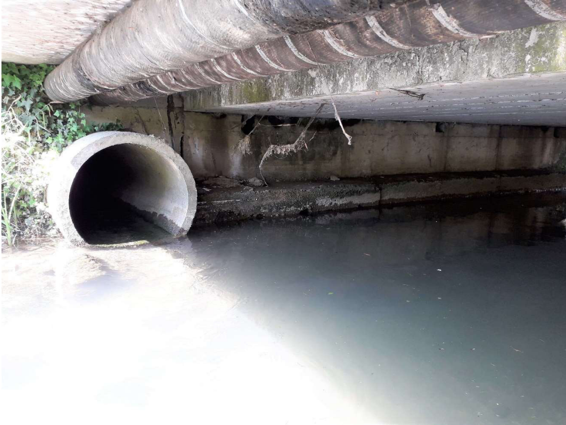
Foto 12 – Rio Rul, attraversamento via IV Novembre, sottoservizi rete gas presenti sotto passerella pedonale
